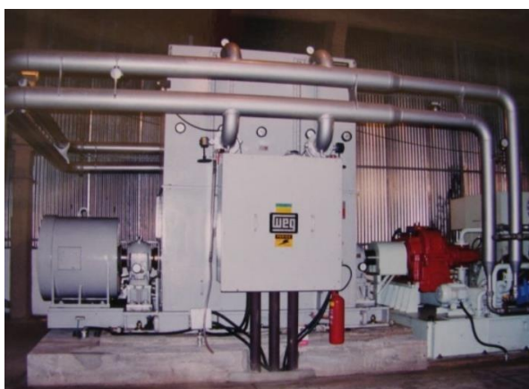
Gerador - 10 MVA - 13,8 KV
