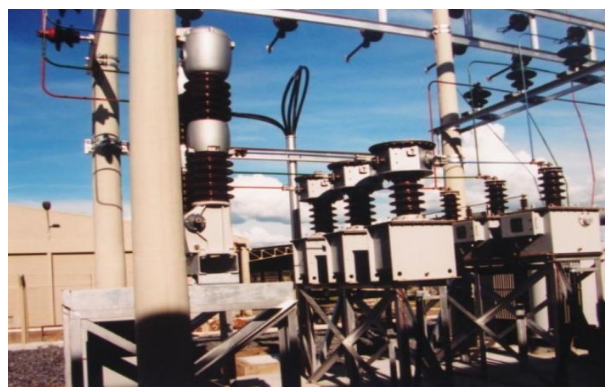
Subestação de paralelismo 34,5 KV - 500 KVA e gerador de parafuso Helicoidal - Arcos.
