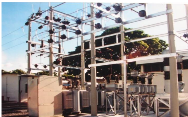
Subestação de paralelismo 34,5 KV - 500 KVA e gerador de parafuso Helicoidal - Arcos.
