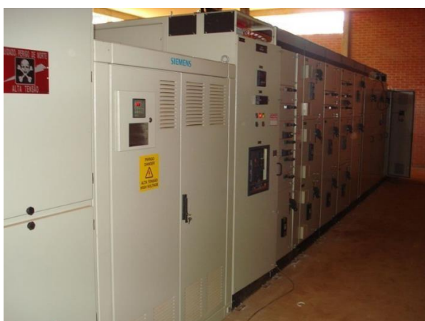
Subestações blindadas (13 instaladas) - 1.5 MVA
