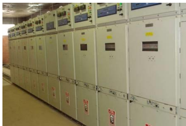
Colunas de cubículos blindados - 13,8 KV - ramais de saída distribuição do gerador 50 MVA.
